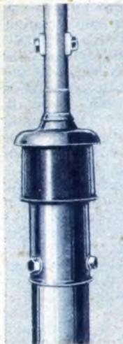
Links: Bild 1. Außenansicht des Isolators bei der neuen Telefunken-Stahlrohrantenne.
